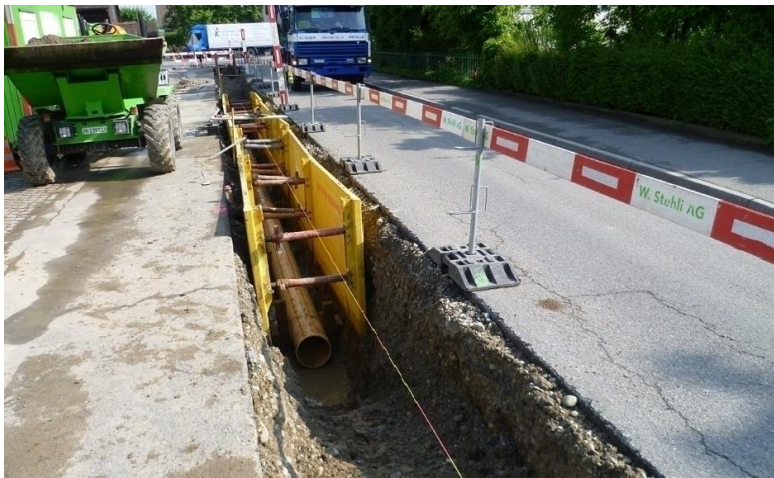
Grabarbeiten Trennsystem
