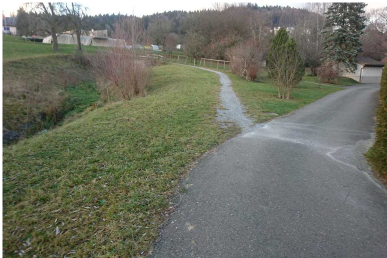
Blick auf das Trasse der geplanten Zufahrtsstrasse "A"
