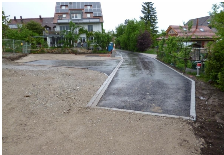
Neu erstellte Wendeanlage
