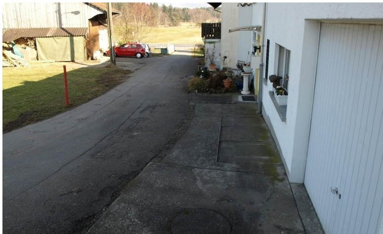
Unterer Bönlerweg vor Sanierungsbeginn
