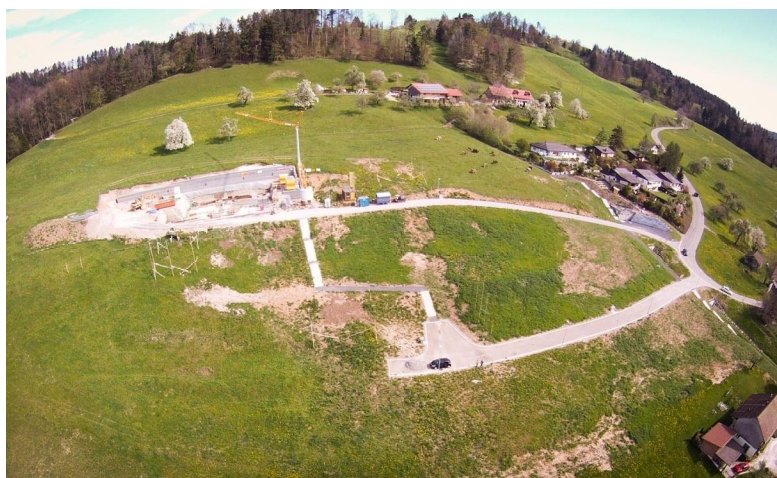
Flugaufnahme der fertig erstellten Erschliessungsanlagen
