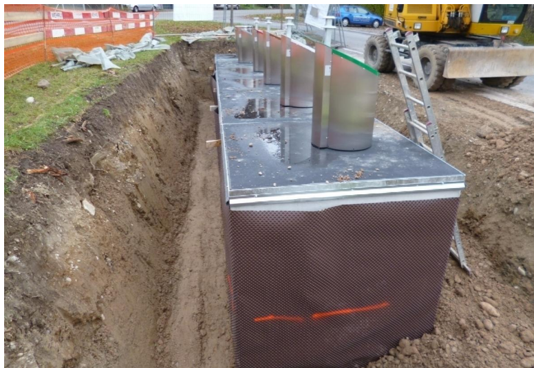
Bauarbeiten Unterflursammelstelle
