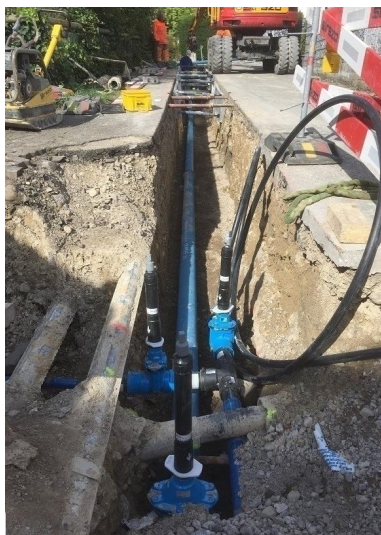
Bauarbeiten Ersatz Wasserleitung
