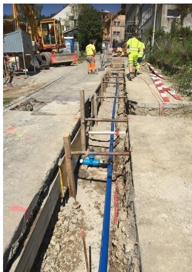
Bauarbeiten Ersatz Wasserleitung
